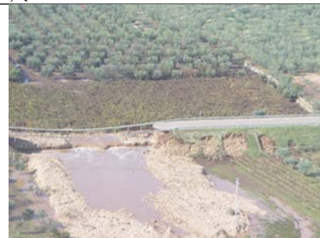
l) Distruzione di un terrapieno stradale tra Cassano e Bitetto.
