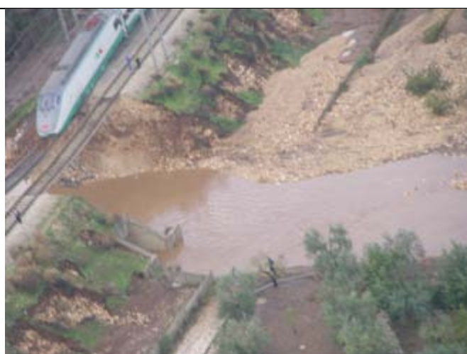
b) Treno Eurostar deragliato. E' evidente il tombino sottodimensionato.
