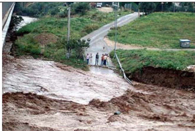
h) Quartiere S. Rita di Bari. Strada distrutta dall'alluvione.
