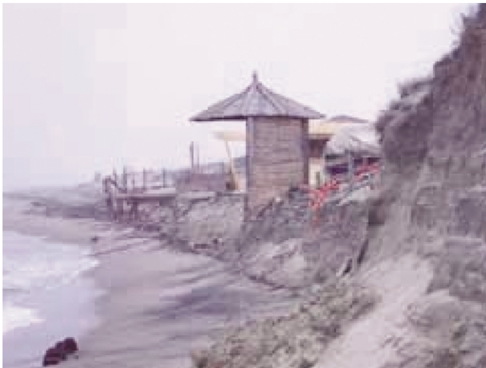
Un esempio di erosione della costa
