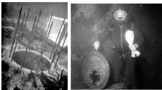
Figura 4.15: Immagine storica del sommozzatore Geom. de Senibus nella fase di posa di una flangia che ospita i trasduttori di pressione.
