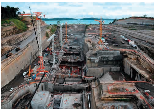
Figura 15 - Una fase dei lavori di ampliamento del Canale di Panama.
