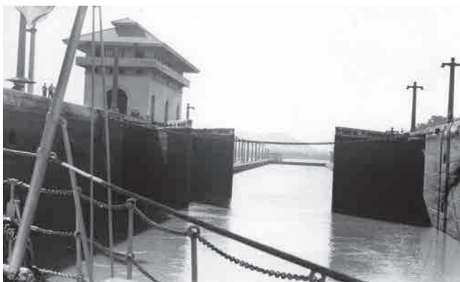
Figura 9 - Un primo piano delle paratoie del Canale di Panama.
