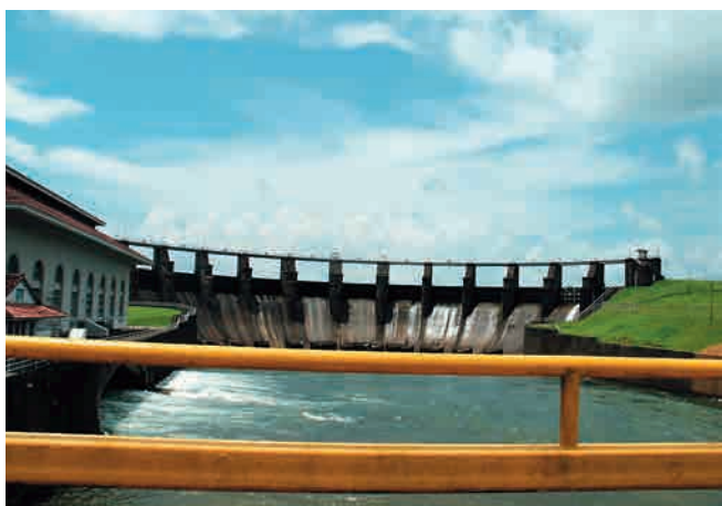
Figura 2 - Sfiatore della diga sul Rio Chagres. La diga è in terra e ha dato origine al Lago Gatún.
