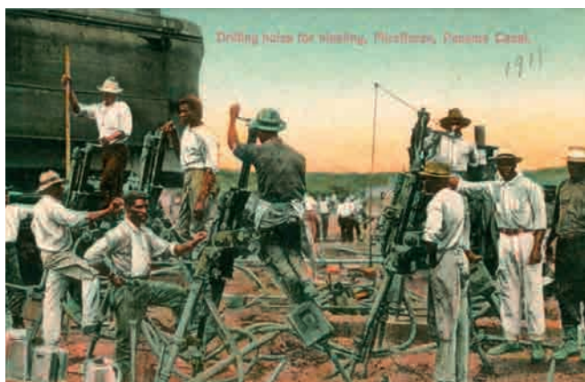
Figura 19 - Cartolina raffigurante una fase di realizzazione dei fori per le mine.
