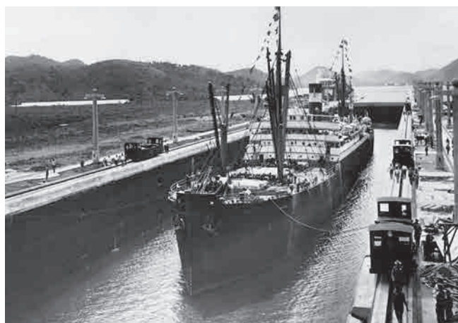
Figura 3 - Vapor Ancón all'inaugurazione del Canale di Panama.
