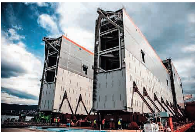
Figura 14 - Le nuove paratoie del Canale di Panama.
