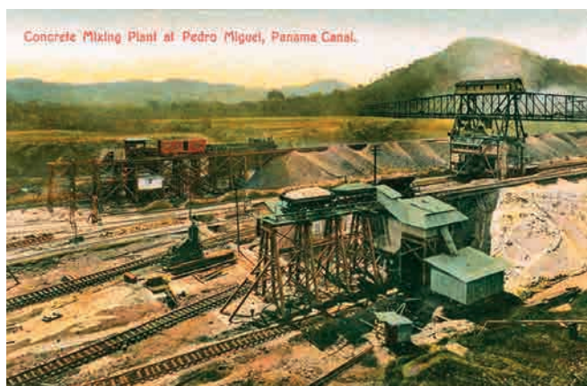
Figura 17 - Cartolina dell'impianto di produzione del calcestruzzo.
