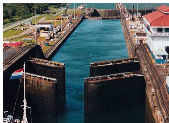
Figura 8 - Un'immagine delle chiuse con le paratoie esistenti del Canale di Panama.
