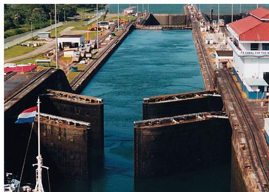
Figura 8 - Un'immagine delle chiuse con le paratoie esistenti del Canale di Panama.
