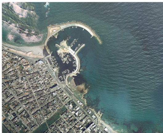
Figura 1. Configurazione attuale del porto di San Foca (Melendugno, Lecce).
